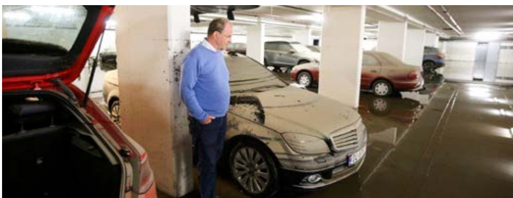
Kjell Thorvald Sørensen er leder i Sameiet i Signalgården på Bekkestua og inspisierer de sørgelige restene av bilene som sto parkert i garasjeanlegget – som ble helt oversvømt på et par korte timer. Foto: Karl Braamaas
