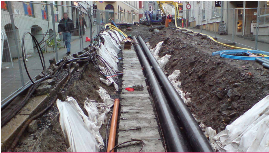
Foto fra rørarbeid i gate/vei.
