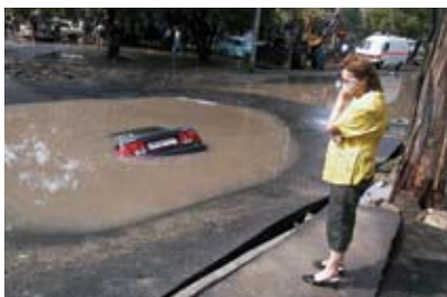
Gatekollaps pga ledningsbrudd (Budapest).
